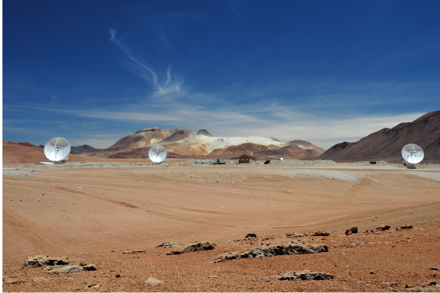
FIGURE 5.7 – Trois des antennes de 12 m de diamètre du grand observatoire submillimétrique ALMA (Atacama Large Millimeter Array) construit par l’Observatoire Européen Austral (ESO), les Etats-Unis et le Japon. L’observatoire est situé à 5200 m d’altitude pour minimiser l’absorption atmosphérique par la vapeur d’eau (Crédit : ESO).
