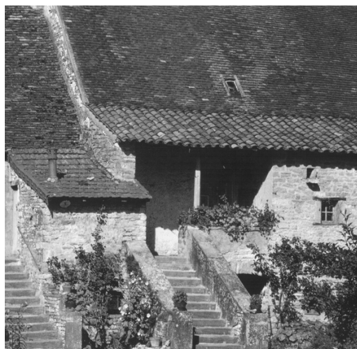
Changement de pente : changement de tuiles /5/.
