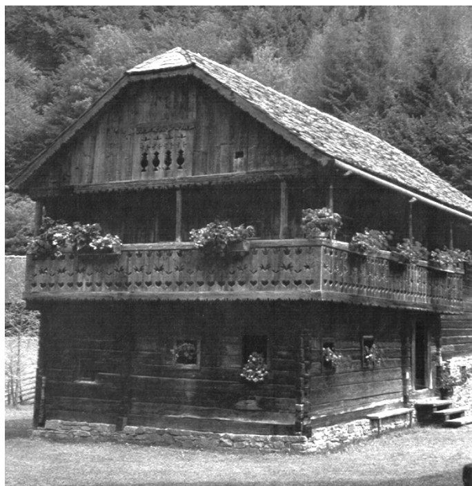
Chalet traditionnel des Alpes, avec couverture de tavillons/3/.
