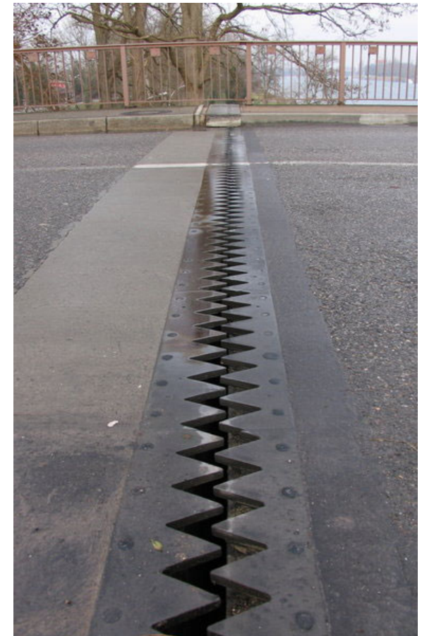
Joint de dilatation thermique d'un pont
