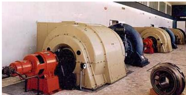
Groupe moteur-pompe du complexe hydroélectrique de la Grande-Dixence
