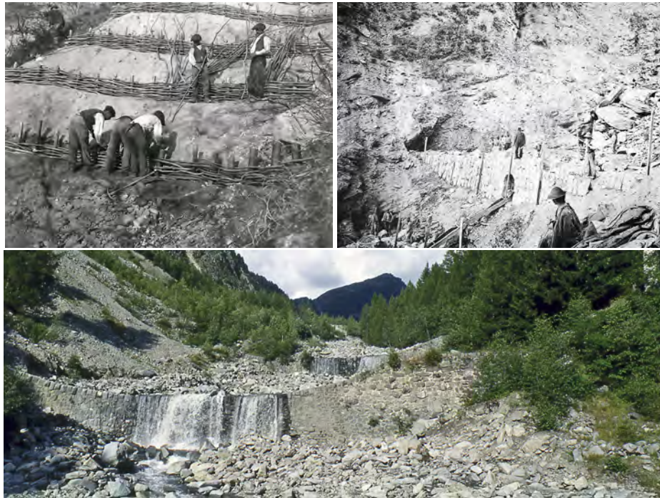
Figure 1.15 – En haut à gauche, travaux de clayonnage sur des berges ; en haut à droite, construction d'un barrage sur le Nant Trouble (Savoie) en 1890. En bas, seuils construits par le service RTM à la fin du xix e siècle sur le Nant Saint-Claude (Savoie). Les deux photographies d'archive sont tirées du livre de Jeudy (2006) .
