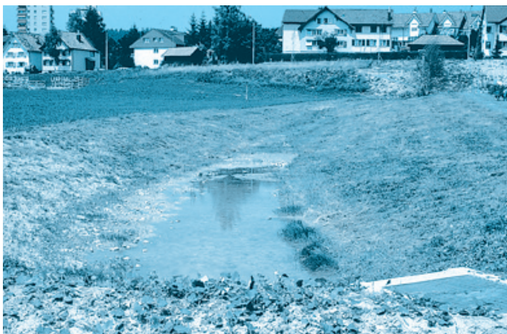
Bassin de rétention et d'infiltration recouvert d'humus
