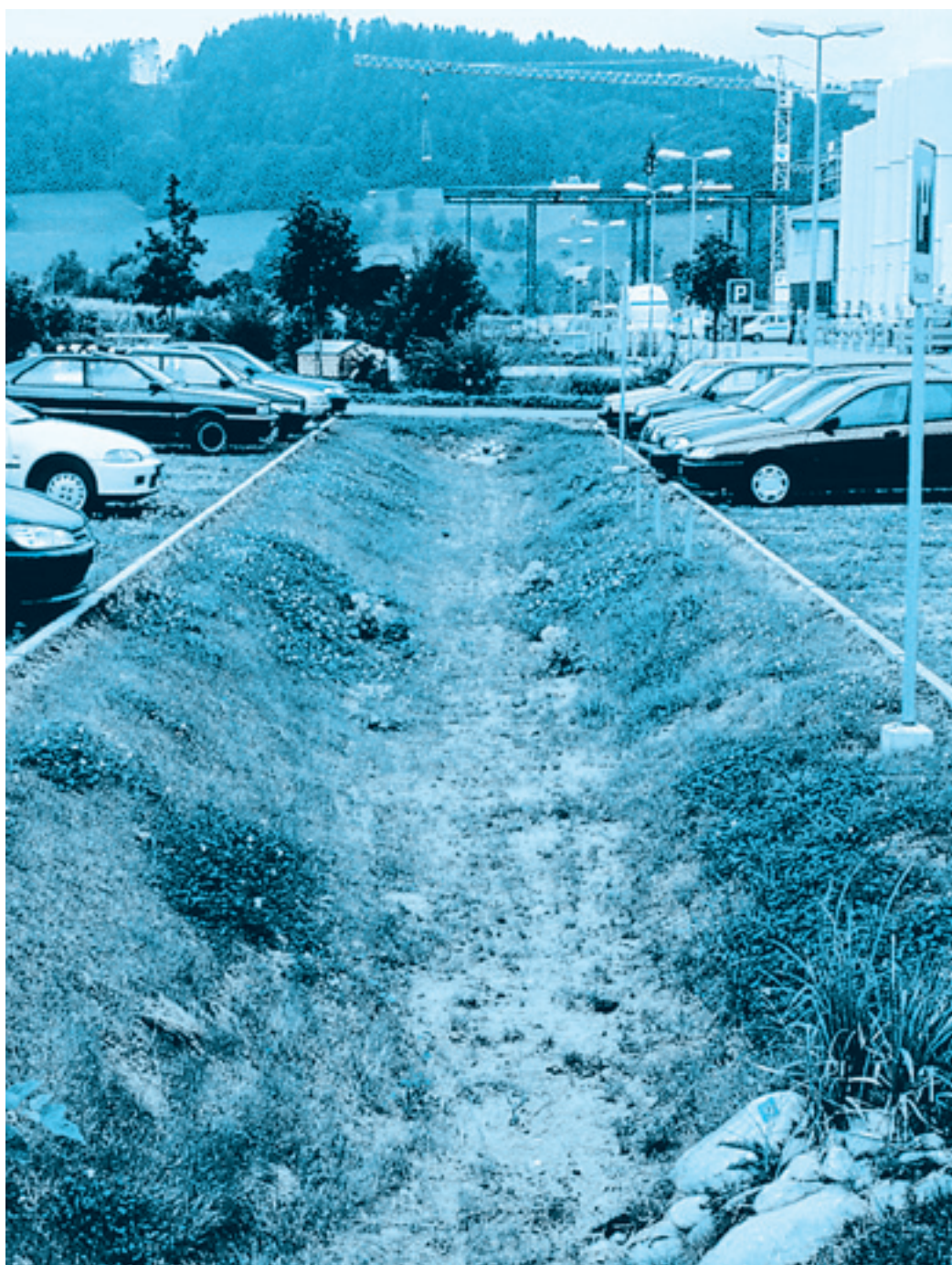
Parking avec une dépression destinée à l'infiltration
