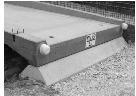
Bild 5. Widerlager, angewouteter Längsträger, Querträger und Spannliedköpfe im Brückenendbereich
