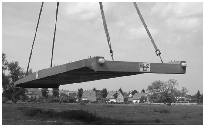
Bild 3. Einschwenken des Brückenüberbaus
