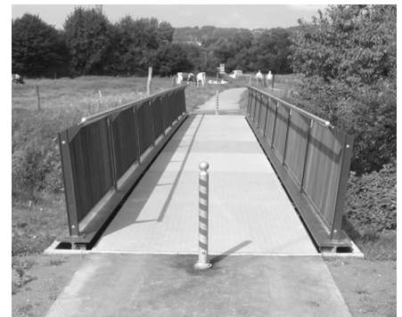
Bild 8. Stahlbrücke mit Brückendeck aus UHFB-Fertigteileplatten
