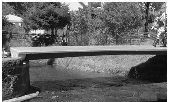
Bild 6. Fuß- und Radwegbrücke mit 9 m Spannweite
