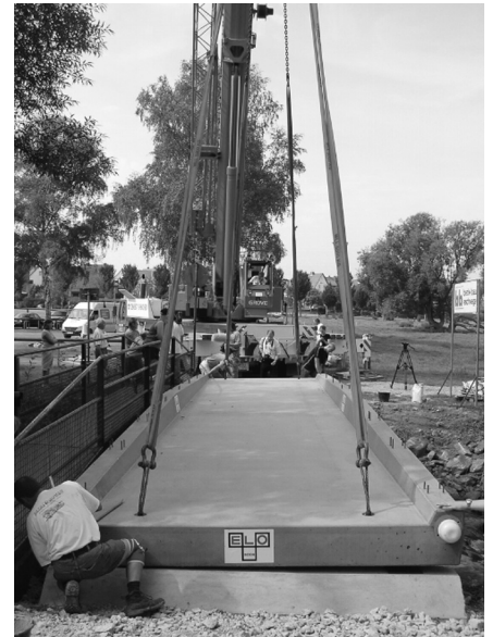
Bild 4. Verlegen und justieren des Brückenüberbaus
