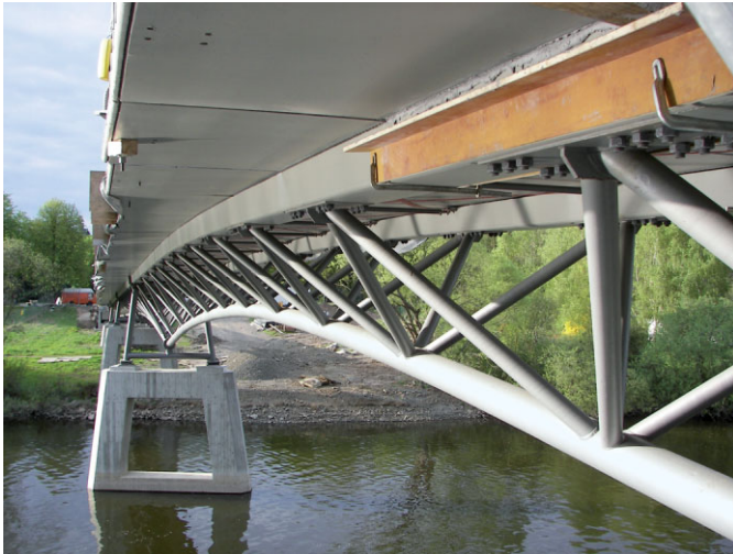
Bild 13. Blick auf die frische Klebfuge zwischen Obergurt und Deckenplatte
