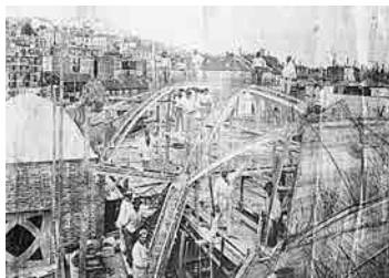
Anatole de Baudot, architecte. Système Cottancin en béton armé. Église Saint-Jean de Montmartre, Paris, 1894 -1904.
