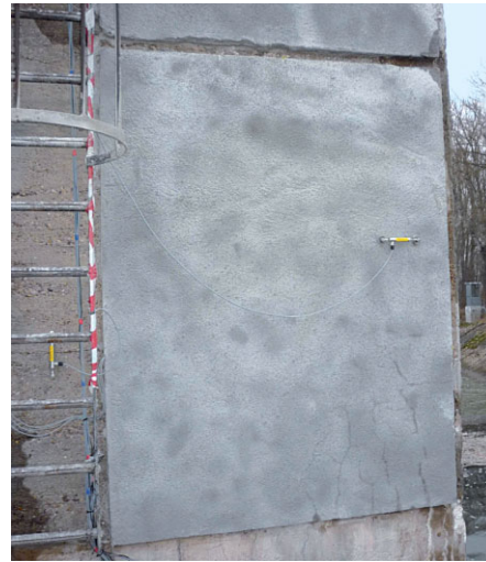
Bild 5 Die instand gesetzten Flächen 1 bis 7 des Pfeilers 3, Wehr Horkheim; rechts: Detailaufnahme einer Fläche View of the repaired surfaces 1-7 of the 3 rd Pillar, Weir Horkheim; right: detail of one surface after repair
