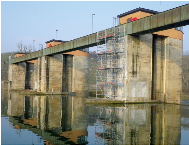
Bild 5 Die instand gesetzten Flächen 1 bis 7 des Pfeilers 3, Wehr Horkheim; rechts: Detailaufnahme einer Fläche View of the repaired surfaces 1-7 of the 3 rd Pillar, Weir Horkheim; right: detail of one surface after repair
