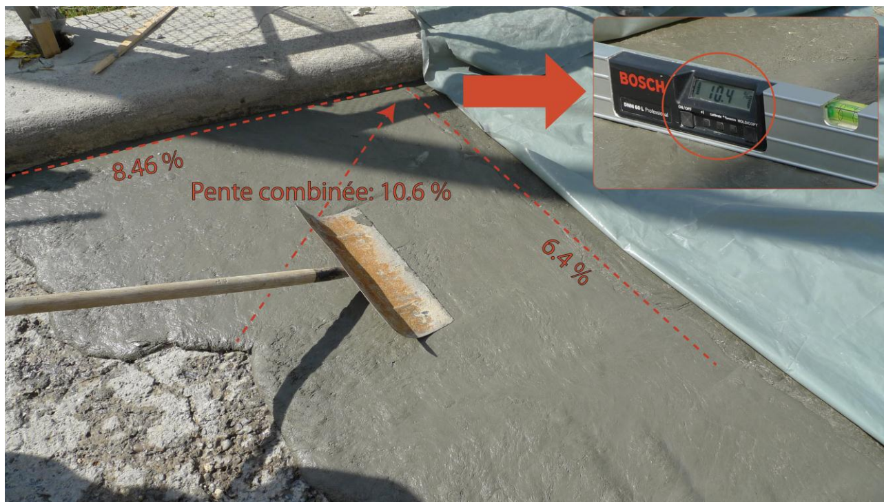
Fig. 4 application d'un BFUP thixotrope (épaisseur 25 mm) sur un ouvrage existant avec une pente combinée de 10.6 %.
