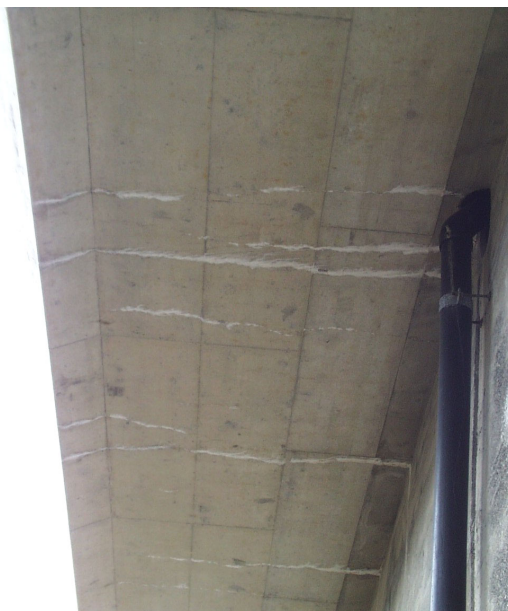
Figure 65 – Vue de la face inférieure de la nouvelle console deux ans après le bétonnage
