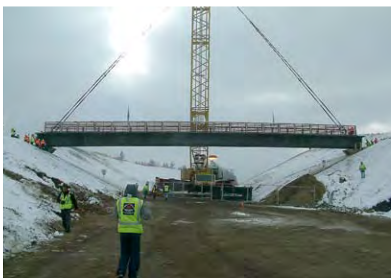
Photos 9 : mise en place à la grue – Source : CETE de Lyon
