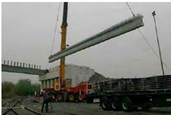
Photos n°4 : mise en place des poutres à la grue – Source : CETE de Lyon
