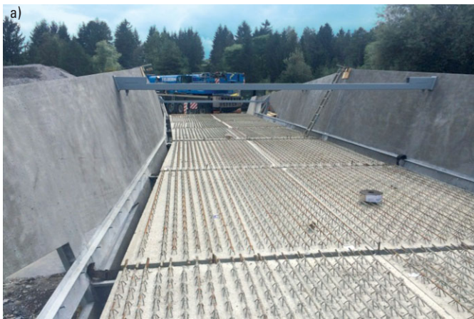
Bild 7 Herstellen der Fahrbahnplatte; a) Verlegen der Bauteil-Fertigteile, b) Betonieren der Fahrbahnplatte mit Hochleistungsbeton ohne Abdichtung Installation deck slab; a) mounting prefabricated elements, b) concreting deck slab with high-performance-concrete without waterproofing
