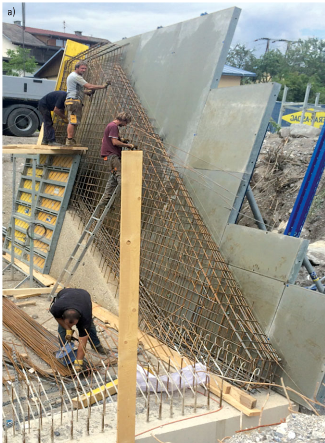
Bild 4 a) Herstellen der Widerlagerflügelwände, b) Geometrie und Herstellungstoleranzen Betonbau \pm 10 mm a) Fabricating of wing wall, b) geometry and concrete producing tolerance \pm 10 mm
