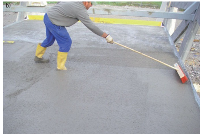
Bild 7 Herstellen der Fahrbahnplatte; a) Verlegen der Bauteil-Fertigteile, b) Betonieren der Fahrbahnplatte mit Hochleistungsbeton ohne Abdichtung Installation deck slab; a) mounting prefabricated elements, b) concreting deck slab with high-performance-concrete without waterproofing
