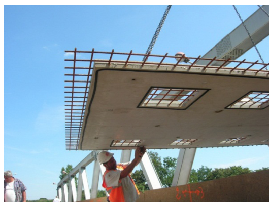
Figure 13 : pose des dalles préfabriquées
