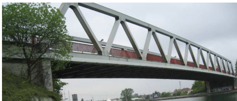
Figure 1 : vue générale de l'ouvrage
