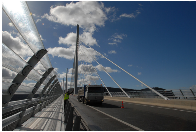
Figure 8 : photos prises lors du chargement du viaduc de Millau à gauche : chargement statique en octobre 2009 ; à droite : charge roulante en octobre 2010
