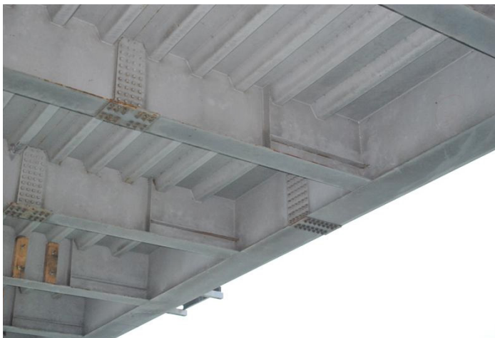
Figure 3 : sous-face du platelage - source : Eiffage TP
