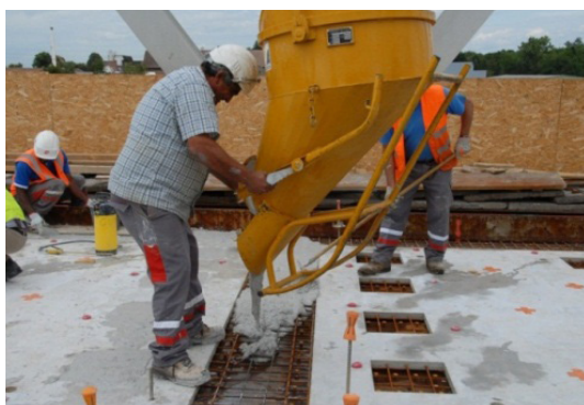
Figure 14 : bétonnage des zones de clavage
