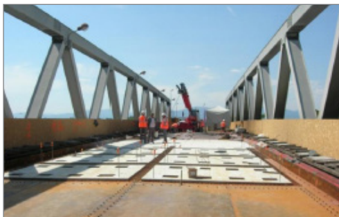
Figure 25 : la réparation du pont d'Illzach
