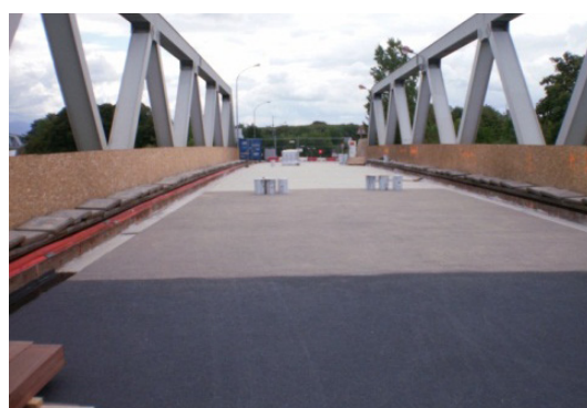
Figure 15 : mise en œuvre de la couche de roulement protectrice
