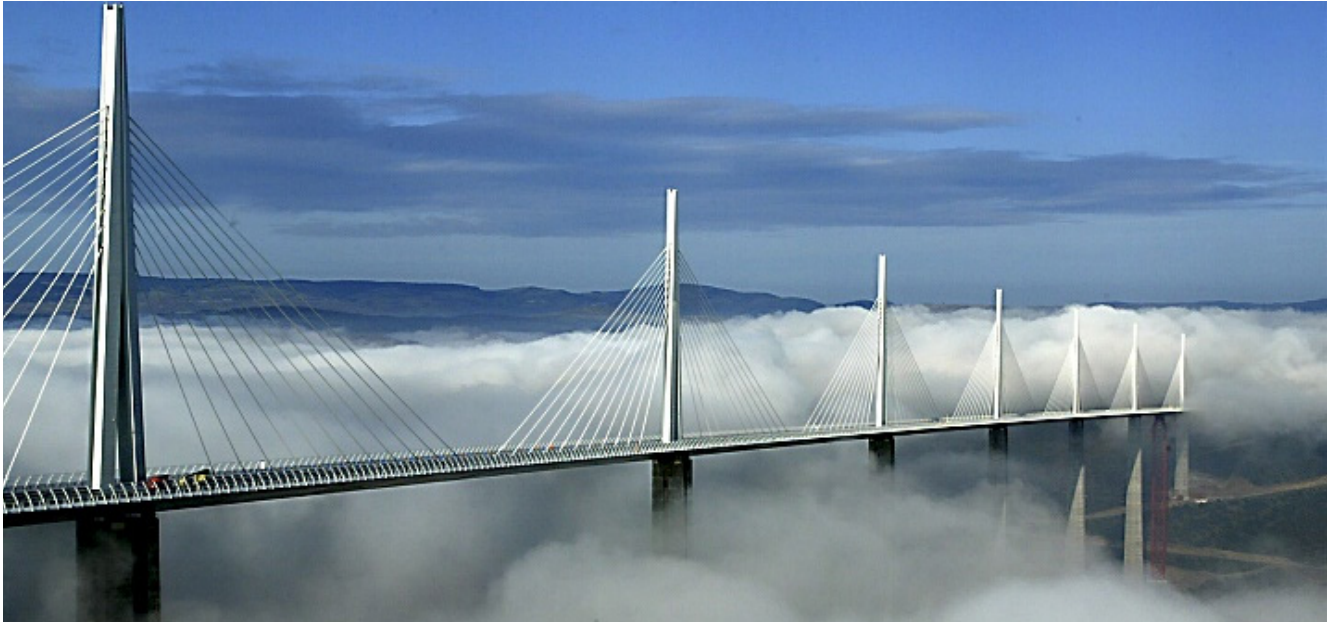
Figure 2 : vue générale du viaduc de Millau
