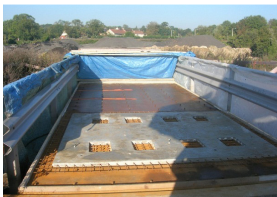
Figure 6 : tablier VMD - Dalle préfabriquée
