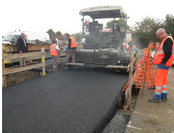
Figure 2 : pose du revêtement Orthochape® sur le corps d'épreuve
