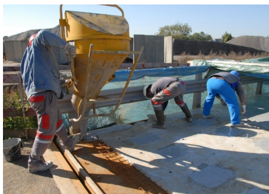
Figure 6 : tablier VMD - Bétonnage des clavages
