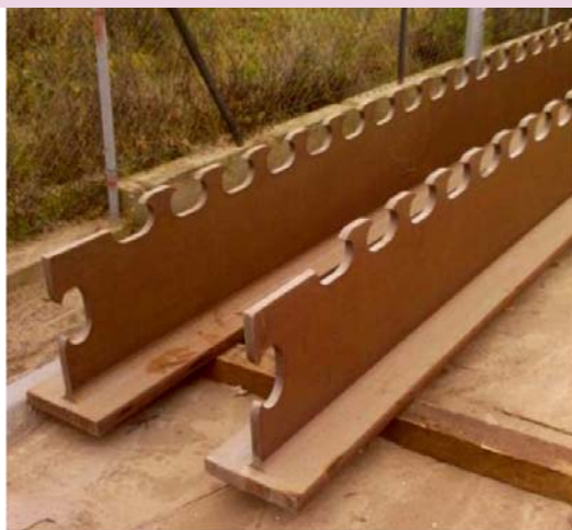
Poutre de pont en construction en Pologne à semelle supérieure béton avec connexion par découpe CL (acier autopatinable)
