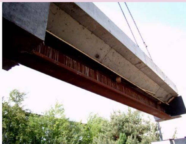
Poutre de pont en construction en Pologne à semelle supérieure béton avec connexion par découpe CL (acier autopatinable)
