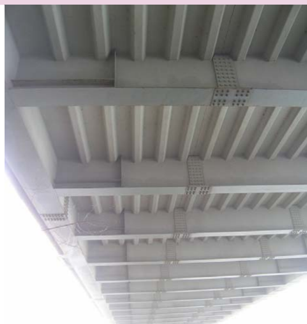
Figure 1 : dalle orthotrope, avec augets discontinus
