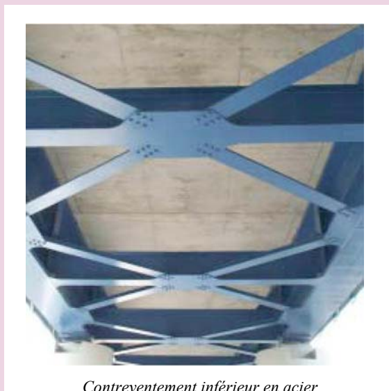
Contreventement inférieur en acier
