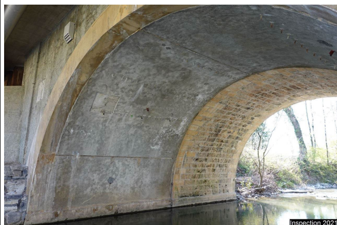
VoDr Voûte Droite 301 Zones humides Distribuées sur tout l'élément. Légère fissuration de la surface visible avec anciennes venues calcaires.
