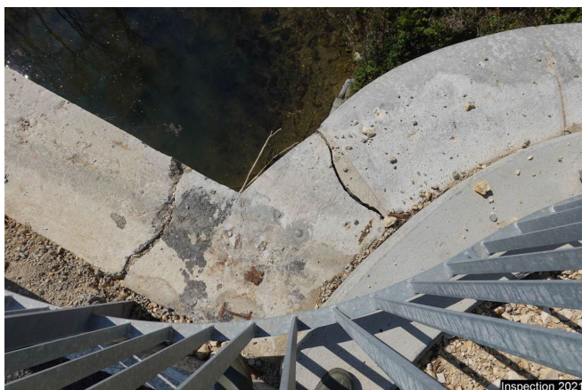
BoGa Bordure Gauche 1216 autres fissures Sur la tête de l'ancienne bordure. Divers fissures et éclats.
