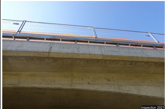
BoDr Bordure Droite 1216 autres fissures Reparties sur toute la bordure. Fissure de retrait.
