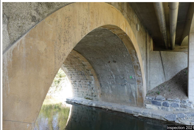
Pd1 Piédroit 301 Zones humides Face interne. Légère fissuration de la surface visible avec anciennes venues calcaires.
