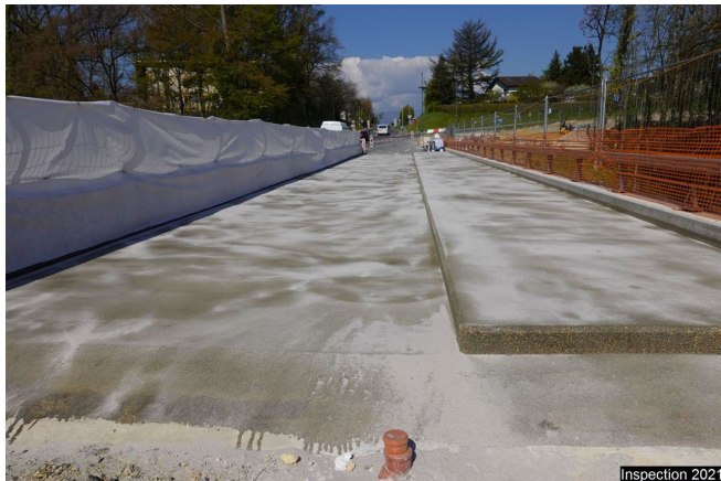
Re Revêtement \ autre constatation Sur l'entier du tablier. Revêtement pas encore posé lors de l'inspection.
