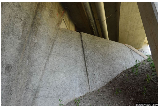
CuDr1 Mur en aile droite axe 1 1209 Fissures dans le joint Joint vertical. Fissure du mortier de crépis.
