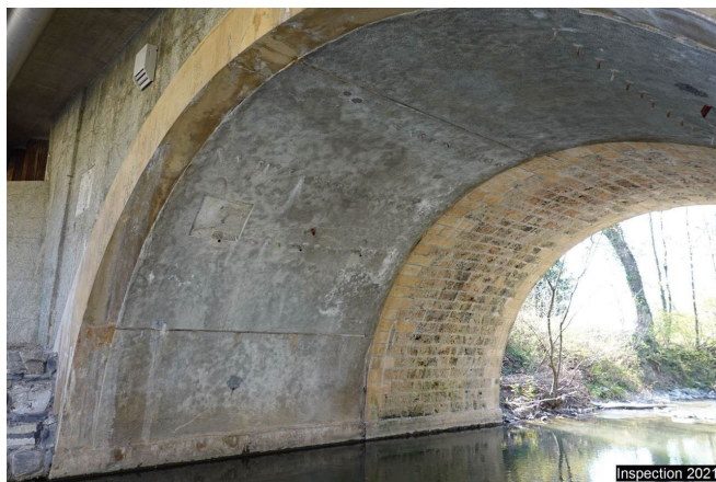
Pd0 Piédroit 1210 Fissures longitudinales Face interne. Légère fissuration de la surface visible avec anciennes venues calcaires.
