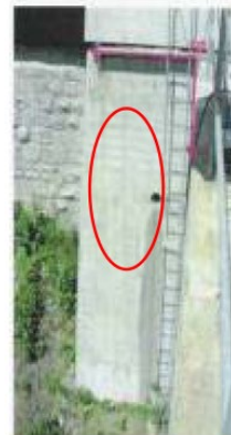
vermutete ein- betonierte Anker
