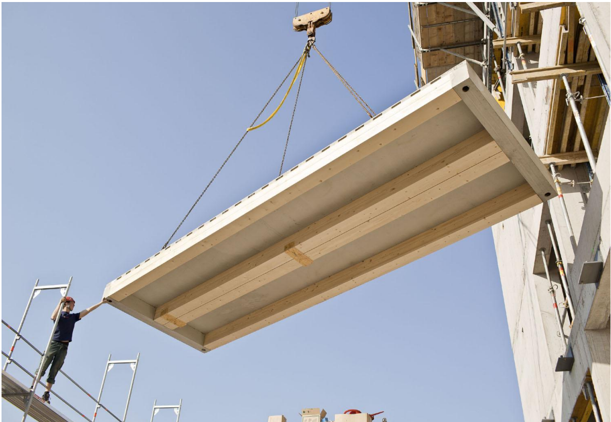
Abbildung 5: Verlegen der Deckenelemente
