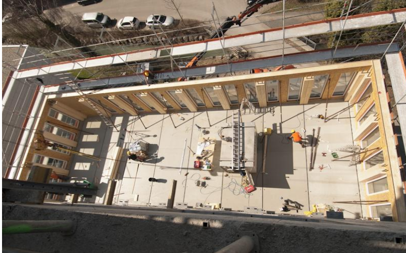
Abbildung 10: Wandelemente mit vorgestellten Stützen
