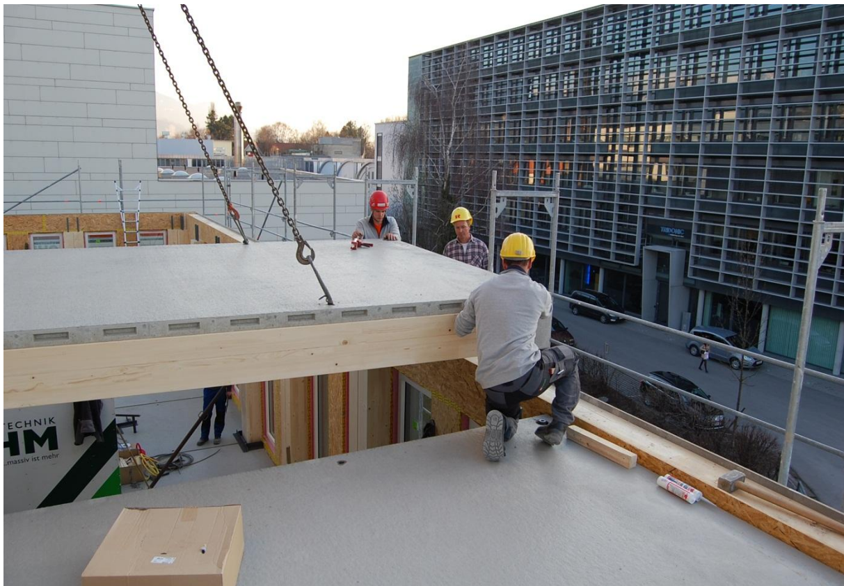
Abbildung 6: Verlegen der Deckenelemente
