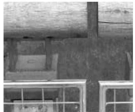
Bild 12.22 a Handlauf aus Rundholz, beim Stoß mit Abstand ausgebildet
