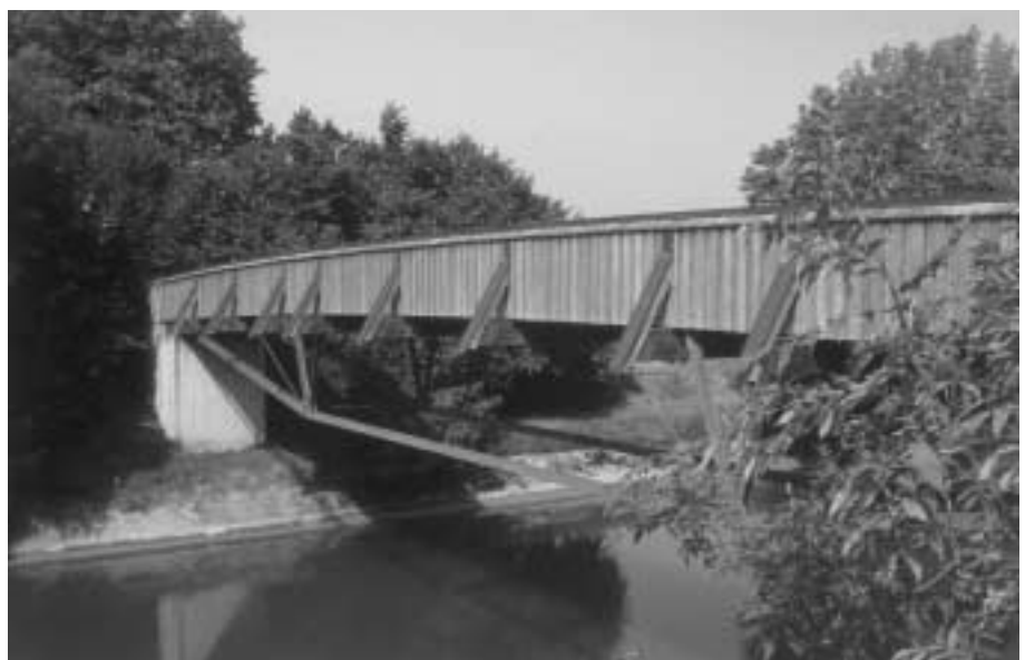
Bild 13.2 Verwendung von resistenten Holzarten als Witterungsschutz
