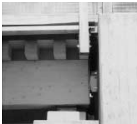
Bild 14.3 zugängliche Lager; Übergang wasserdicht
