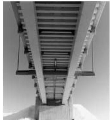
Bild 14.4 wasserdichte Fahrbahnplatte mit Überstand
