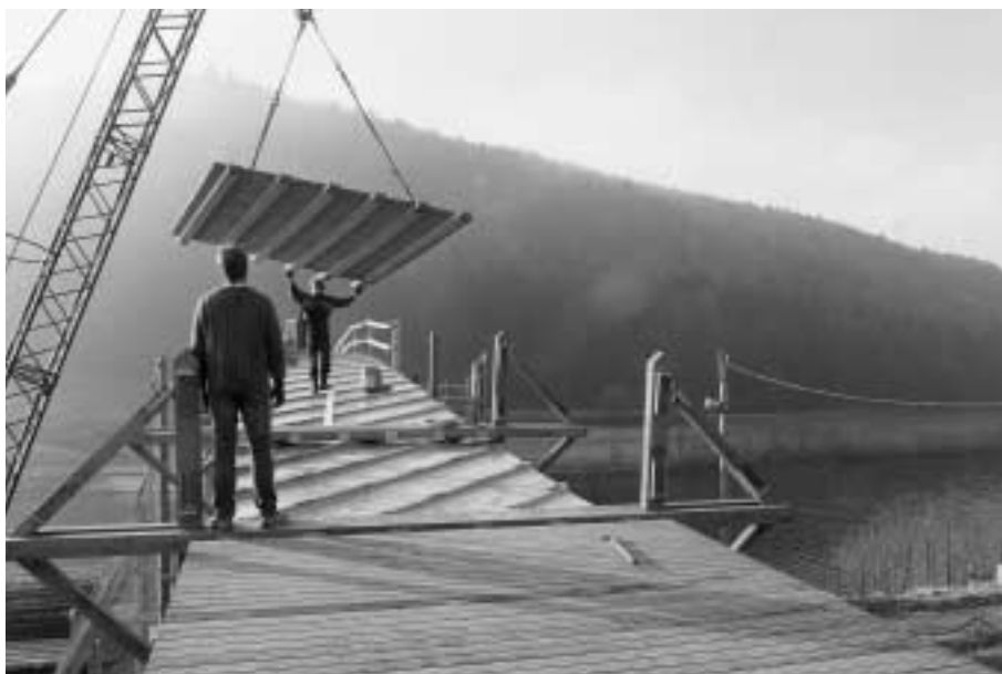
Bild 2.10 Bohlenrost auf Blechabdeckung
