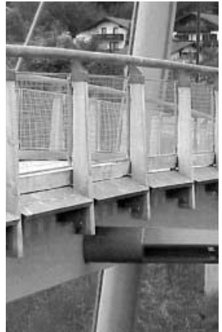
Bild 12.21 Geländer mit Holzpfosten, Holzhandlauf und Füllung aus Stahlgitter, seitlicher Schutz des Brückenträgers über eine schräge Bohle
