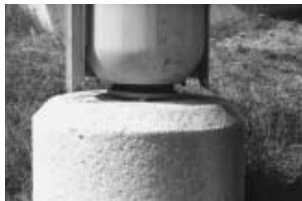
Bild 14.2 Abdeckung Stützenfuß
