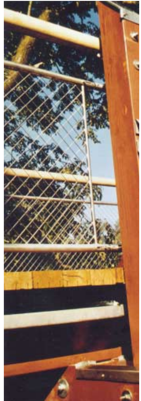
abgestrebter Geländerpfosten und abgedeckte Querträge
