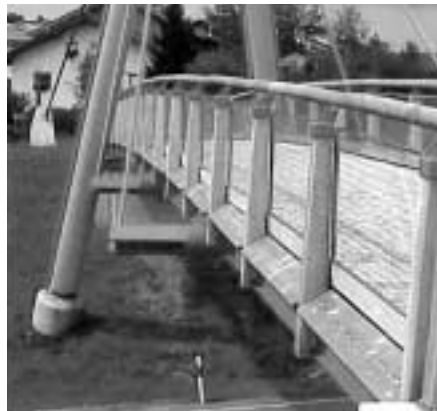
Bild 14.1 Abschirmung der Bauteile mit Wetterschutz und Schrammbord
