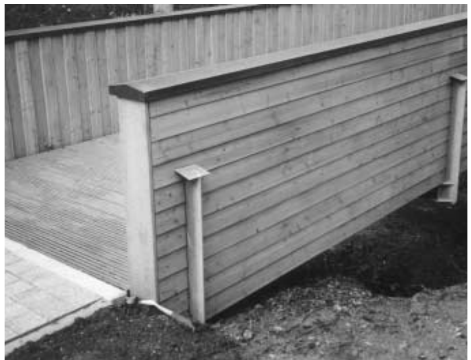
Bild 4.6 Trogbrücke mit seitlicher Bekleidung des Hauptträgers; außen horizontal, innen vertikal
