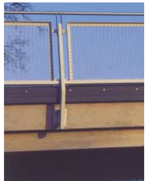
seitlicher Geländeranschluss bei einer blockverleimten Brücke
