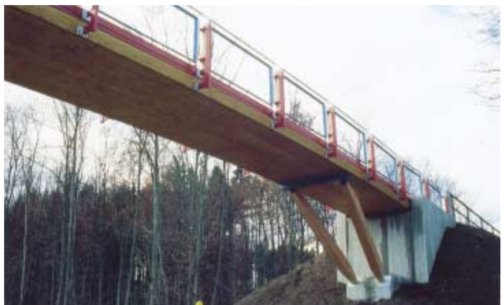
seitlicher Geländeranschluss bei einer abgestrebt blockverleimten Brücke
