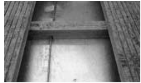
Bild 2.16 Bohlenrost auf Blechabdeckung (hier fehlt der Abstand zwischen Blech und Längsträger, im First tolerierbar)
