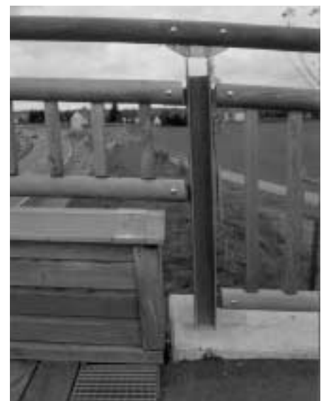
Bild 6.4 Obere Abdeckung eines Hauptträgers
