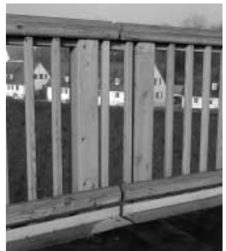
Bild 12.22 b Handlauf profiliert, beim Stoß mit Abstand ausgebildet
