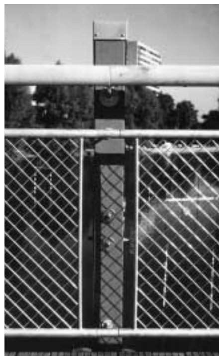
Bild 12.8 Geländerfüllung mit Stahlgitter
