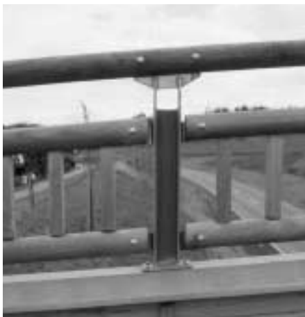
Bild 12.12 Aufgesetztes Geländer einer Trogbücke
