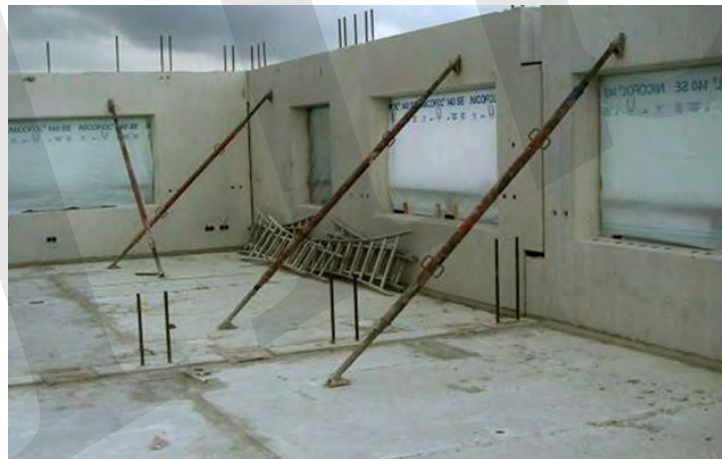
Fig. 4-15: Precast wall panels with deep nibs for vertical shear connections (used in Het Strijkijzer).
