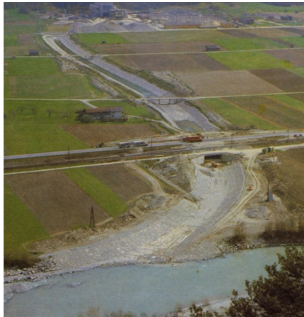
Figure 1.1 Canal de restitution lors de la construction
