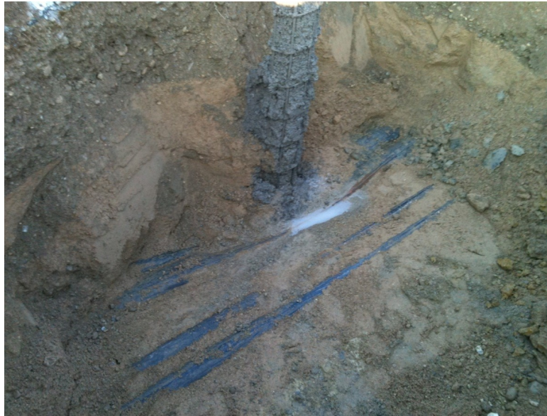
Forage dans câbles Moyenne Tension
