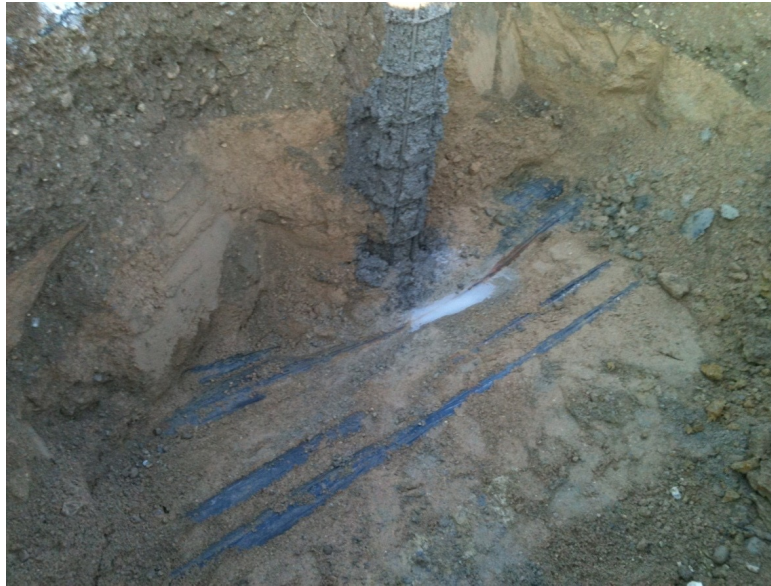
Forage dans câbles Moyenne Tension
