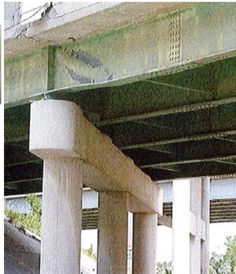
Ruine d'une poutre de pont
