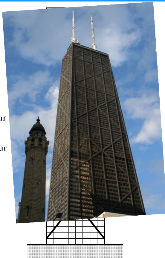
(b) Façades avec contreventement en treillis
