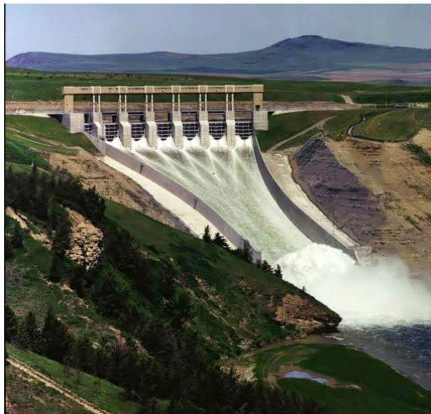
Figure 1 –: Exemple d'évacuateur de crue avec une convergence.
