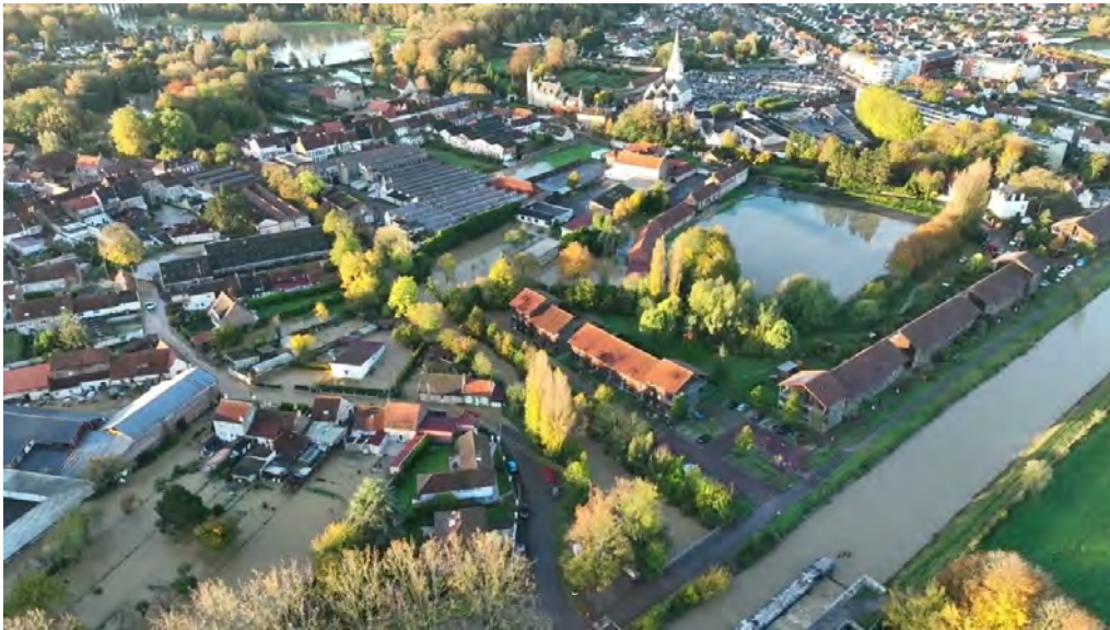
Figure 2.37 – Inondations de janvier 2024 à Arques (France, Pas-de-Calais). Source: AFP .
