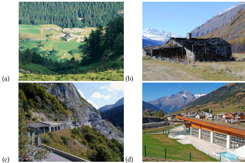
Figure 3.7 – (a) Étrave devant l’église de Vallorcine (Haute-Savoie) construite au début du xviii e siècle pour protéger l’église et le presbytère; (b) étrave accolée au bâtiment à protéger (Bessans, Savoie); (c) galerie protégeant la route de Mieussy (Haute-Savoie) contre les avalanches et les chutes de blocs; (d) à Lanslevillard (Savoie), la piscine est protégée des avalanches par sa toiture.
