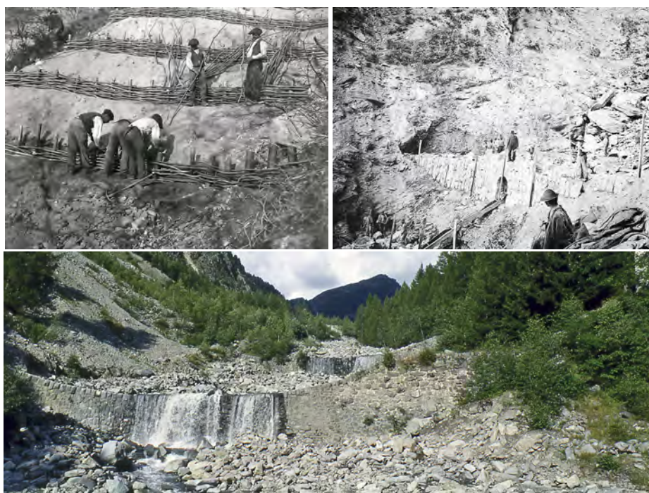
Figure 1.15 – En haut à gauche, travaux de clayonnage sur des berges ; en haut à droite, construction d'un barrage sur le Nant Trouble (Savoie) en 1890. En bas, seuils construits par le service RTM à la fin du XIX e siècle sur le Nant Saint-Claude (Savoie). Les deux photographies d'archive sont tirées du livre de Jeudy (2006) .
