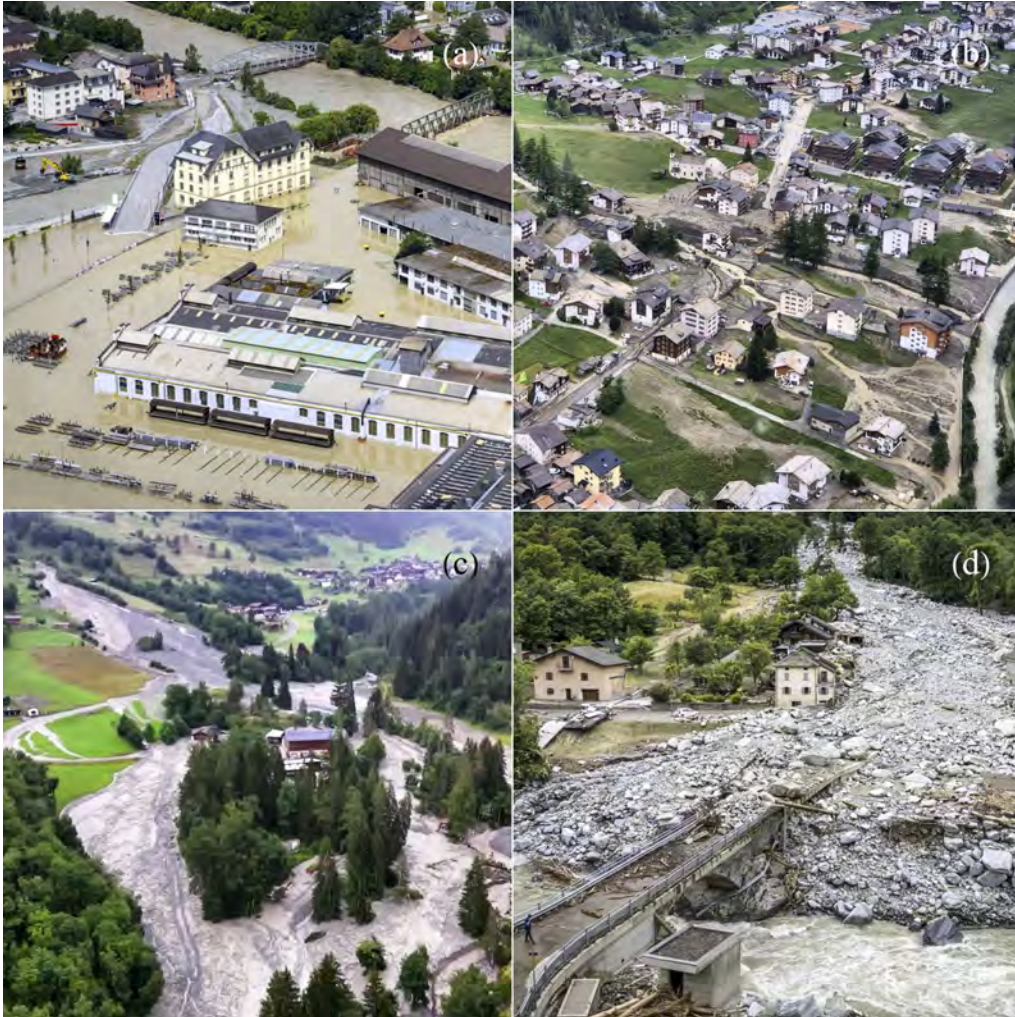
Figure 2.28 – Inondations et crues de la fin juin 2024. (a) Zone industrielle de Chippis noyée sous les eaux de la Navisence le 30 juin 2024. Source: Olivier Maire, Le Temps . (b) Saas Grund (VS) touché par une lave torrentielle, qui fait un mort. Source: RTS . (c) La haute vallée de Bagnes coupée du reste du Valais par une lave torrentielle le 6 juillet 2024. Source: RTS . (d) Val Mesolcina (GR) touché par des coulées torrentielles. Source: Swiss Info .
