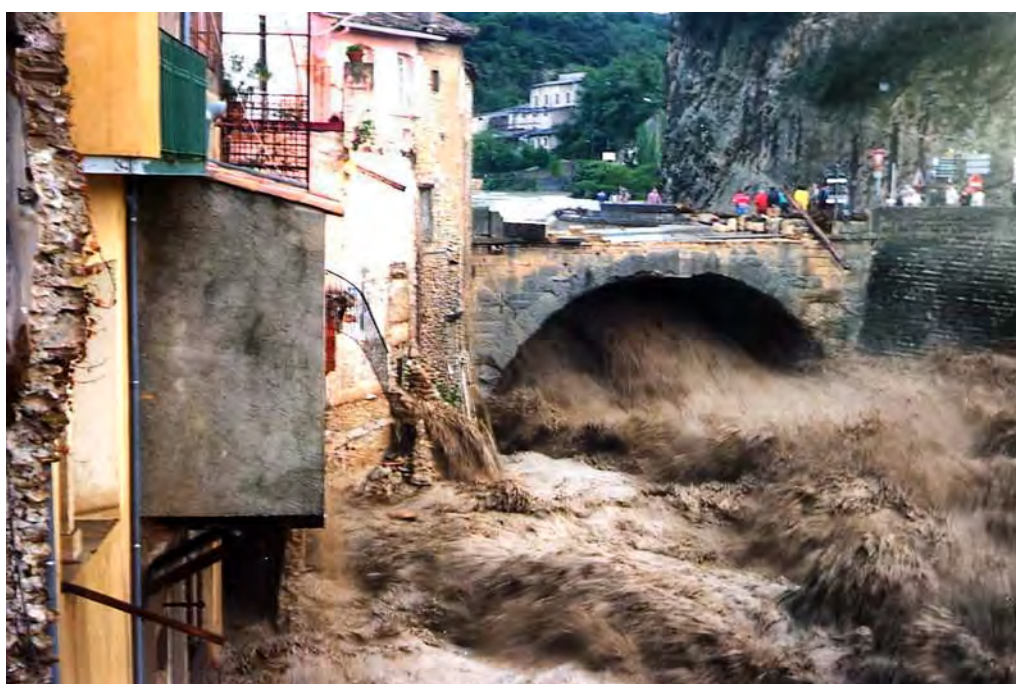
Figure 2.27 – Le pont romain de Vaison-la-Romaine (Vaucluse, France) lors de la crue de l'Ouvèze le 22 septembre 1992. Source : J.-M. Tricart .
