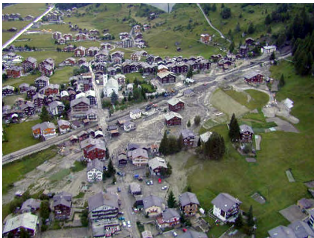
Figure 2.51 – Le village de Täsch après la crue du Täschbach en juin 2001. Source : Crealp.
