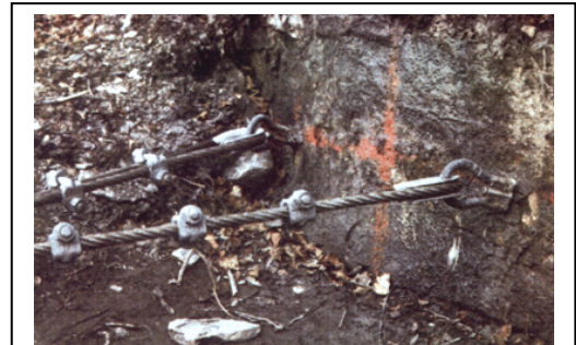
Figure 41. Ancre dans le roc
