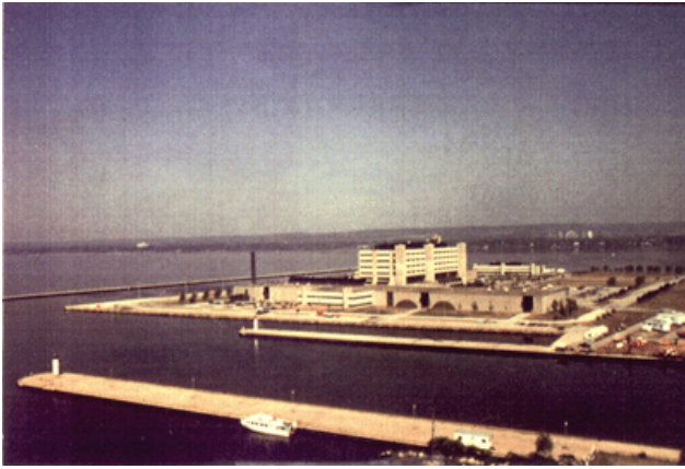
Figure 2. Vue du Centre canadien des eaux intérieures depuis le Burlington Skyway Bridge
