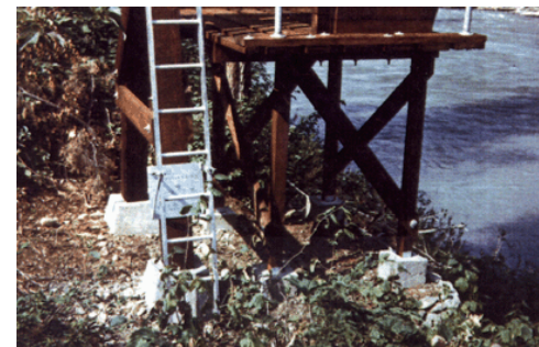
Figure 37. Base en béton
