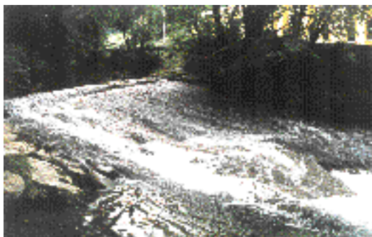
Fig. 8d: Rampe unie, peu rugueuse; dalle de béton
