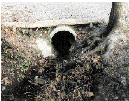
Fig. 10d: Passage en tuyau de béton
