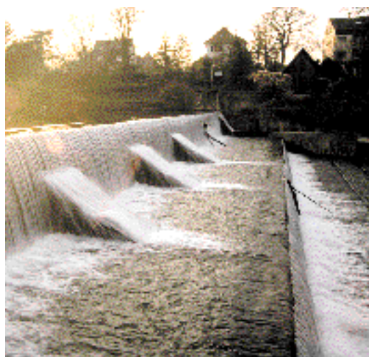
Fig. 7e : Seuils bétonnés à l'intérieur d'un ouvrage de retenue à quatre niveaux
