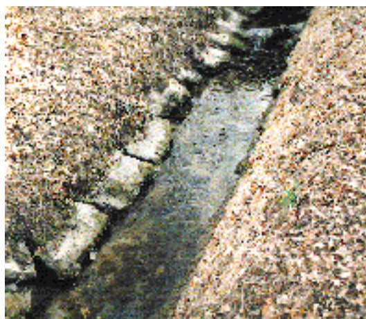
Fig. 2f : Cours d'eau sans variabilité de la largeur du lit mouillé; lit géométrique
