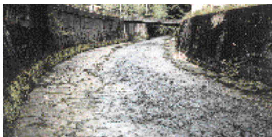
Fig. 3d: Cours d'eau avec un aménagement complet et imperméable du fond; pavage de pierres
