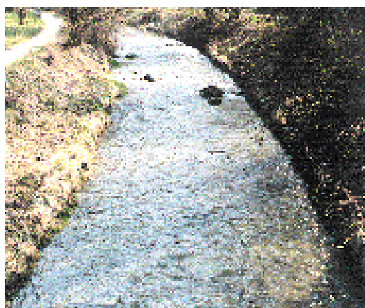
Fig. 2e : Cours d'eau sans variabilité de la largeur du lit mouillé. La végétation croissant dans le lit provoque bien une très faible variabilité de largeur, mais qui n'a presque aucune influence sur le courant.
