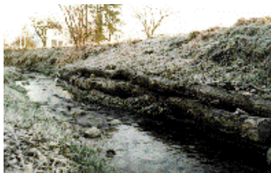
Fig. 4d: Cours d'eau avec un renforcement perméable du pied de la berge: protection des berges en bois
