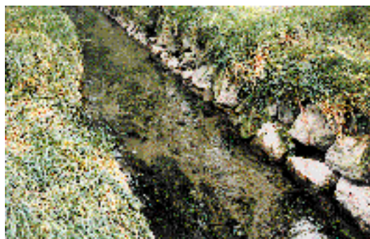
Fig. 4c: Cours d'eau avec un renforcement perméable du pied de la berge: pierres naturelles lâches, entièrement aménagé (100%); assemblage de blocs non taillés avec des interstices irréguliers et relativement grands
