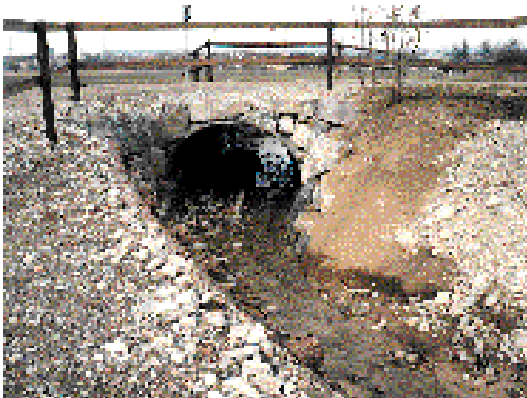
Fig. 10e: Passage en tuyau Armco
