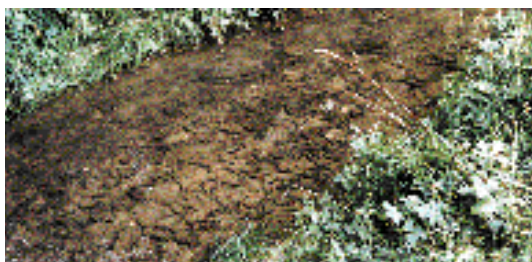
Fig. 3b: Cours d'eau avec un aménagement complet du fond (100%); empierrement artificiel
