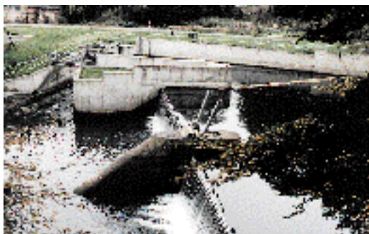
Fig. 9a: Digue - réservoir pour le prélèvement d'eau
