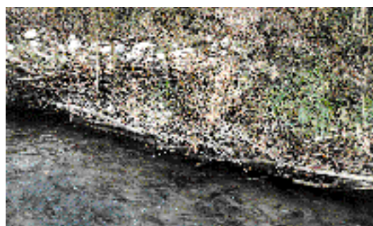
Fig. 4a: Cours d'eau à renforcement du pied de la berge perméable: (matériel végétal vivant; on reconnaît des branches de saules entrelacées qui commencent à pousser et dont les racines protégeront bientôt la berge.
