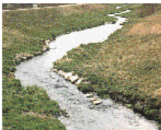
Fig. 4b: Cours d'eau avec un renforcement perméable du pied de la berge: pierres naturelles lâches, moyennement aménagé (10-30%); pied de berge seulement partiellement protégé par des pierres naturelles
