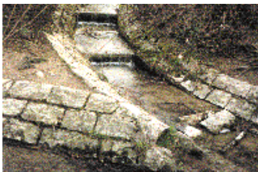
Fig. 3a: Cours d'eau avec un aménagement ponctuel du fond. Seuils artificiels isolés ou autres aménagements ponctuels présents sur moins de 10% de l'ensemble du fond du lit du tronçon. Le degré d'aménagement du fond est proportionnel au nombre d'aménagements transversaux.
