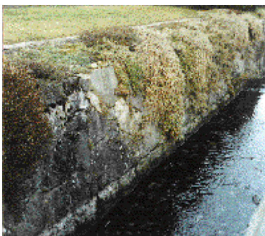
Fig. 4g: Cours d'eau avec un renforcement imperméable du pied de la berge: mur, entièrement endigué (100%)
