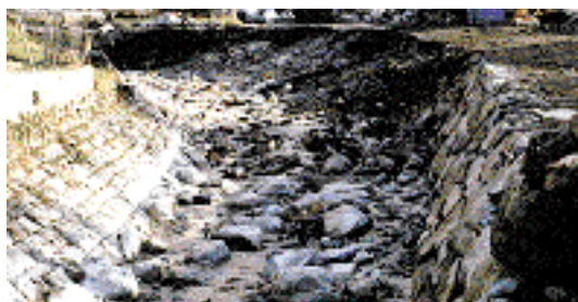
Fig. 3c: Cours d'eau avec un aménagement complet du fond (100%); enrochement artificiel
