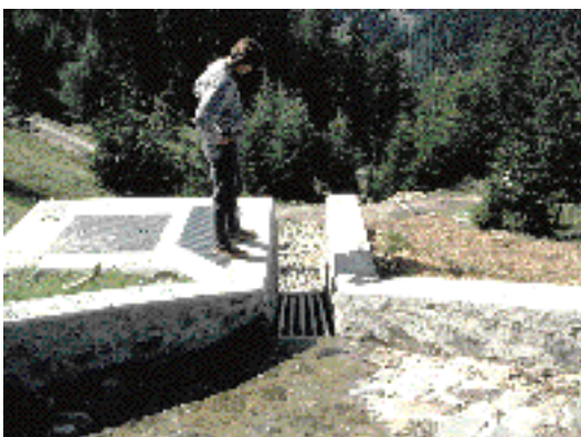
Fig. 9c: Prise tyrolienne
