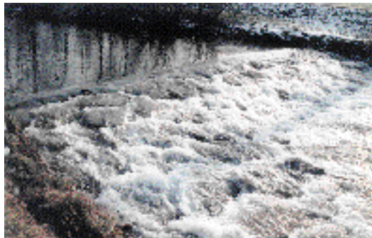
Fig. 8c: Rampe rugueuse, en pierres ajustées
