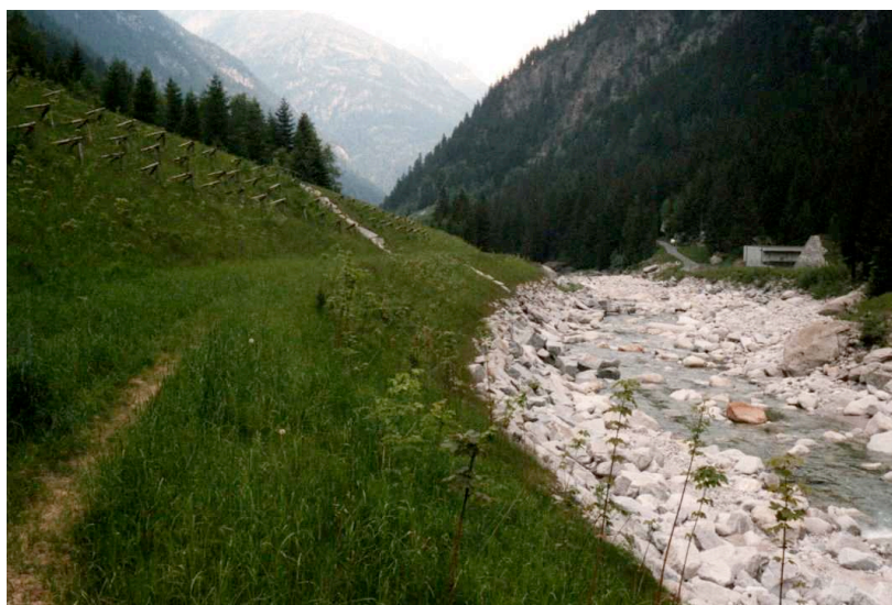
Figure 5. Enrochement partiellement recouvert par de la terre végétale. Photo prise durant le 2ème été après la fin des travaux.
