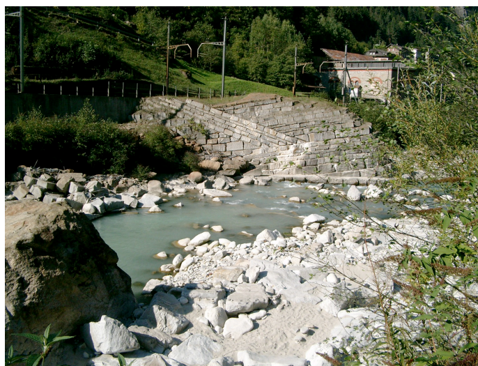
Figure 3: Eperon rocheux artificiel destiné à stabiliser les méandres de Gurnellen-Wiler.
