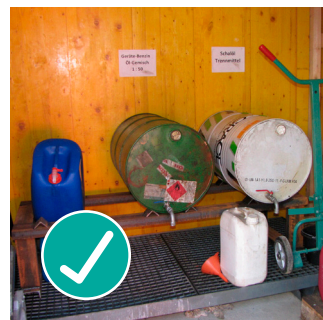
Entreposage avec bac de rétention
