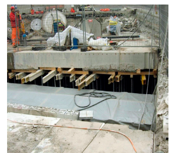
Travaux de fraisage
