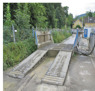
Installation de lavage des roues
