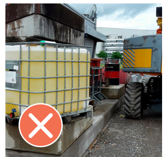
Bac de rétention manquant, distance trop faible par rapport à la machine de chantier
