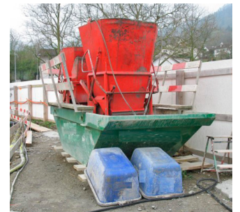
Exemple de lavage de bacs au-dessus de bennes pour la restitution avec un camion-bétonnière
