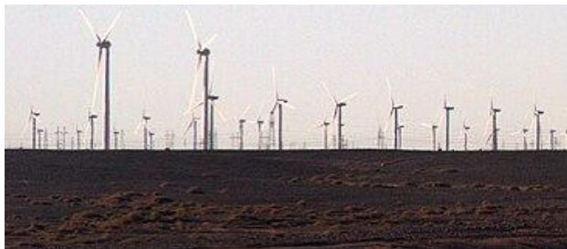
Ferme éolienne de Gansu, Chine Puissance: 10 GW
