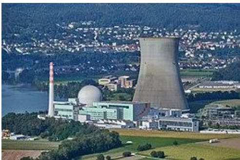
Centrale nucléaire de Leibstadt, Suisse Puissance: 1.2 GW
