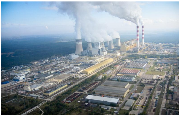
Centrale thermique de Belchatow, Pologne Puissance: 5.42 GW
