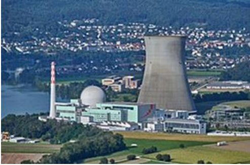
Centrale nucléaire de Leibstadt, Suisse Puissance: 1.2 GW
