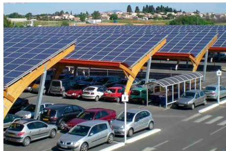
Ombrière photovoltaïque pour parking, Saint-Aunès, France Puissance: 1,15 MW
