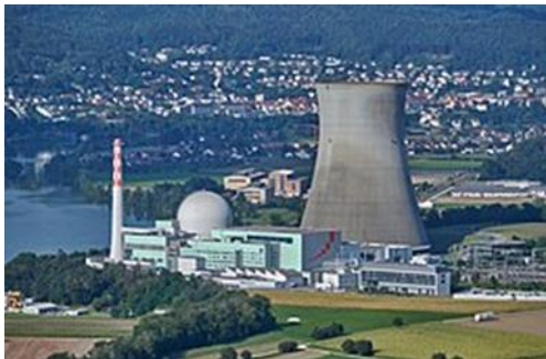
Centrale nucléaire de Leibstadt, Suisse Puissance: 1.2 GW
