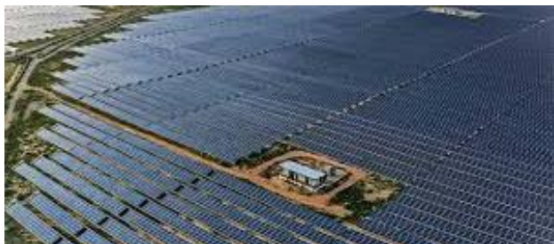
Centrale solaire photovoltaïque de Bhadla, Inde Puissance: 2,2 GW
