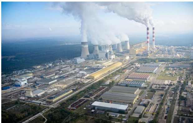
Centrale thermique de Belchatow, Pologne Puissance: 5.42 GW
