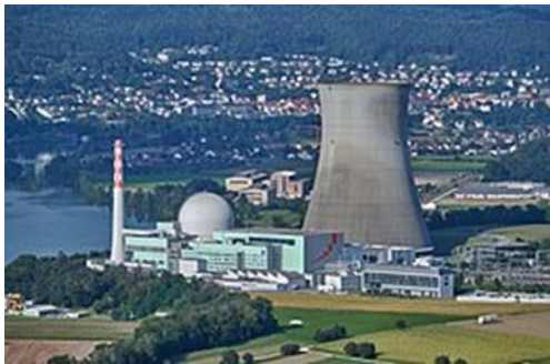
Centrale nucléaire de Leibstadt, Suisse Puissance: 1.2 GW
