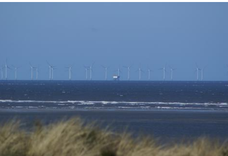
Parc éolien de Horns Rev, Danemark Puissance: 0.8 GW
