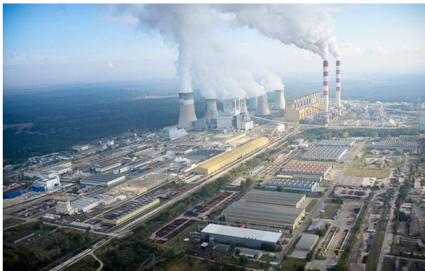
Centrale thermique de Belchatow, Pologne Puissance: 5.42 GW
