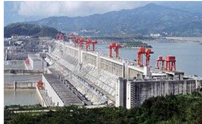
Centrale hydroélectrique des trois gorges, Chine Puissance: 22.5 GW
