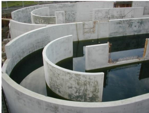
Bâtiment agricole (Slagstar 340 kg/m 3 , w/b = 0,50)
