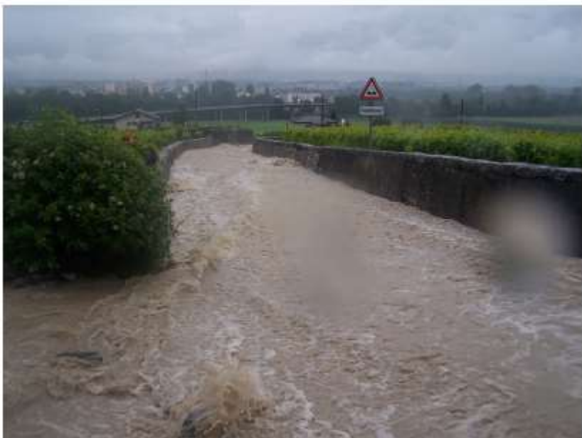
Photo 4: Ecoulement sur la route de Corbeyrier, vu de l'amont (photo prise le jeudi 9 août 2007 vers 11h00).
