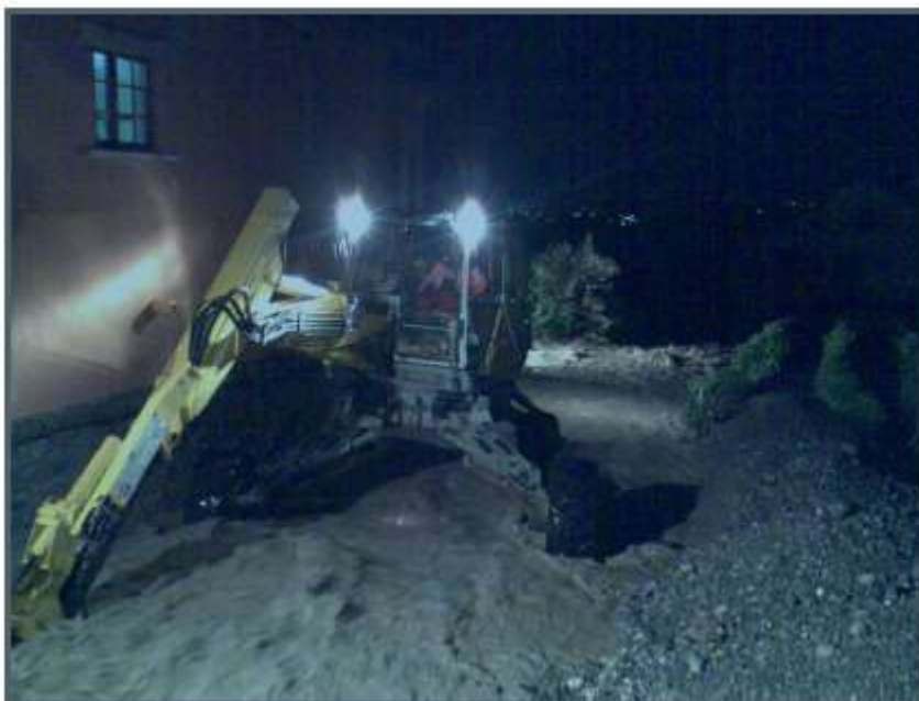
Photo 1: Travaux de curage réalisés à l'aval du voûtage passant sous la place du village (photo prise par M. Alain Rouge le mercredi 8 août 2007 vers 22h40).
