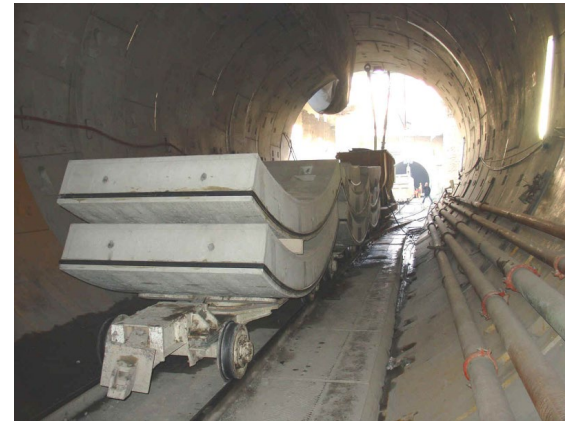
Érection des anneaux de voussoir (tunnelier avec bouclier): ca. 20-40 min. par anneau
