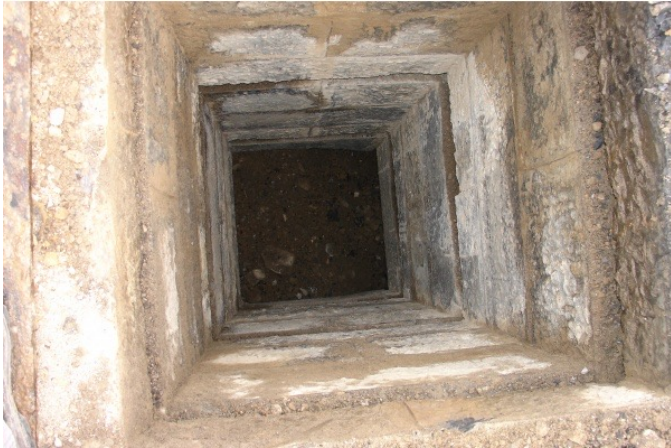
puits de mine
