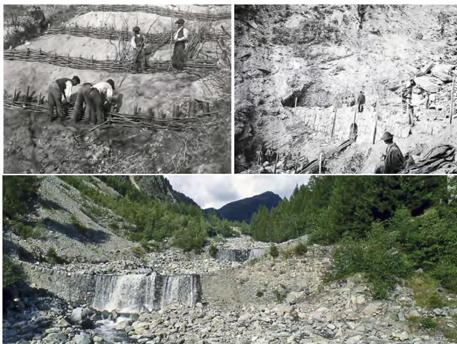
**Figure 1.15** – En haut à gauche, travaux de clayonnage sur des berges ; en haut à droite, construction d'un barrage sur le Nant Trouble (Savoie) en 1890. En bas, seuils construits par le service RTM à la fin du XIX<sup>e</sup> siècle sur le Nant Saint-Claude (Savoie). Les deux photographies d'archive sont tirées du livre de [Jeudy \(2006\)](#).
