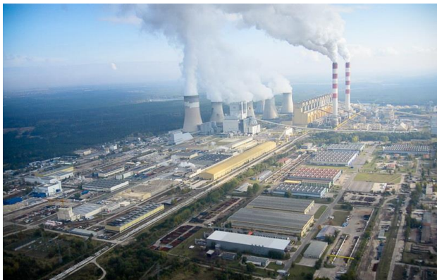
Centrale thermique de Belchatow, Pologne Puissance: 5.42 GW
