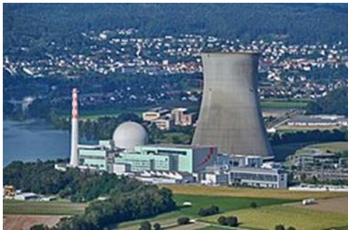
Centrale nucléaire de Leibstadt, Suisse Puissance: 1.2 GW
