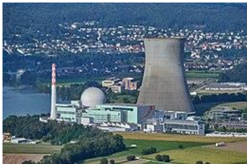
Centrale nucléaire de Leibstadt, Suisse Puissance: 1.2 GW
