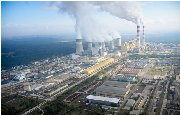
Centrale thermique de Belchatow, Pologne Puissance: 5.42 GW
