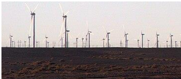
Ferme éolienne de Gansu, Chine Puissance: 10 GW
