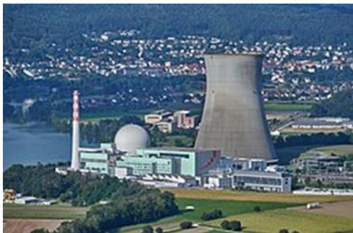
Centrale nucléaire de Leibstadt, Suisse Puissance: 1.2 GW
