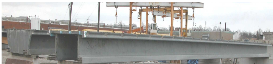
Aperçu général / General overview
