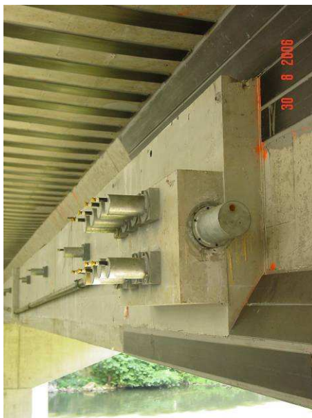
Renforcement des poutres existantes avec du BSI® / Strengthening of the existing beams with BSI®
