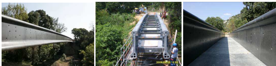
Aperçu général / General overview
