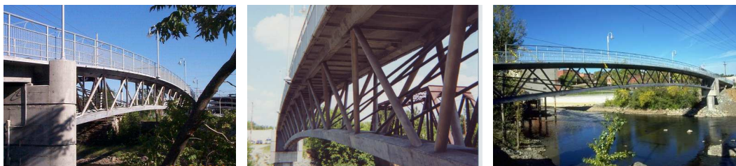
Aperçu général / General overview
