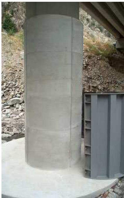
Renforcement des piles du pont avec du BSI® / Reinforcement of bridge piers with BSI®
