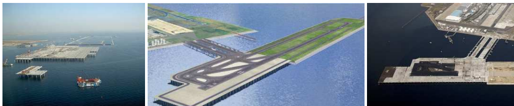
Aperçu général / General overview
