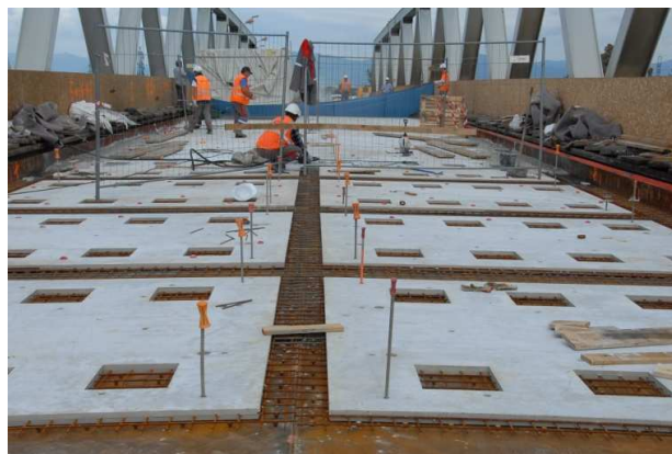
Pose des éléments préfabriqués / Installation of precast elements
