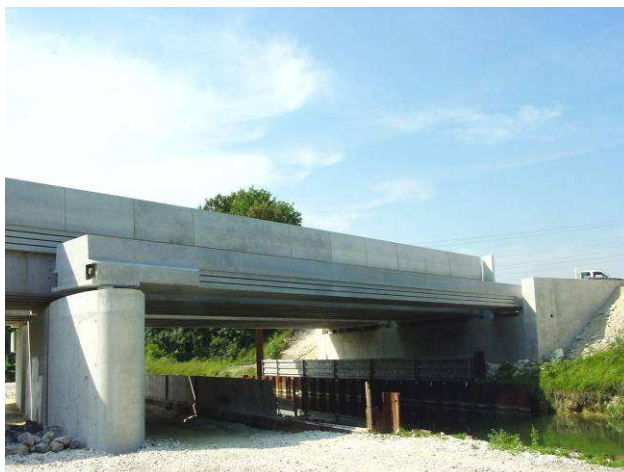
Aqueduc constitué de 3 parties préfabriquées / Aqueduct made of 3 precast segments
