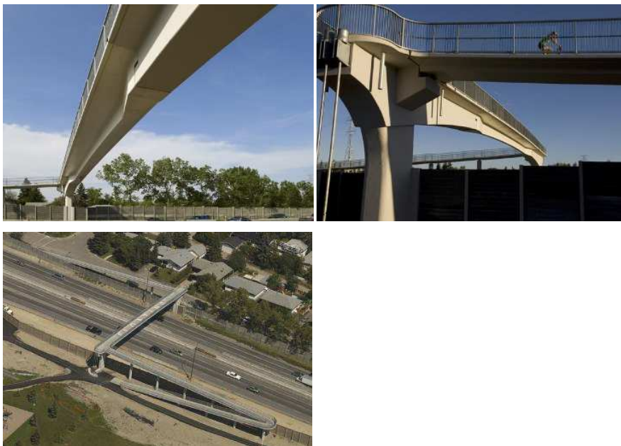
Aperçu général / General overview
