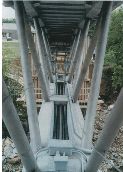
Bild 2.5: Darstellung der externen Vorspannung [2.3]
