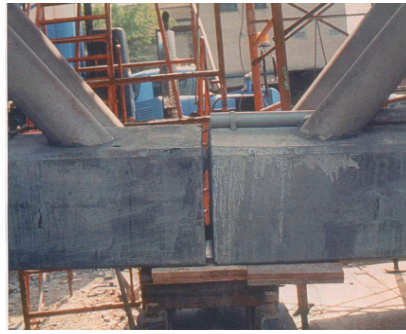
Bild 2.10: Stoßstelle zweier Elemente in einem Brückensegment [2.3]
