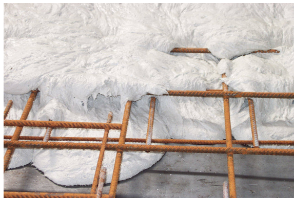
Bild 4.3: UHFB mit Fasern beim Umfließen der Bewehrung
