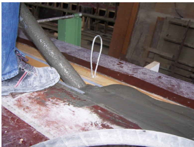
Bild 4.7: Einbringen von UHFB in die Schalung der Deckenplatten für die Gärtnerplatzbrücke
