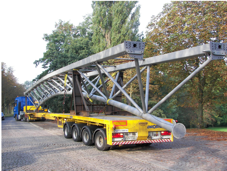
Bild 2.19: Vorgefertigtes 36 m langes Mittelteil der Brücke mit angeschraubten, nachträglich gebogenen Obergurten aus vorgespanntem UHFB
