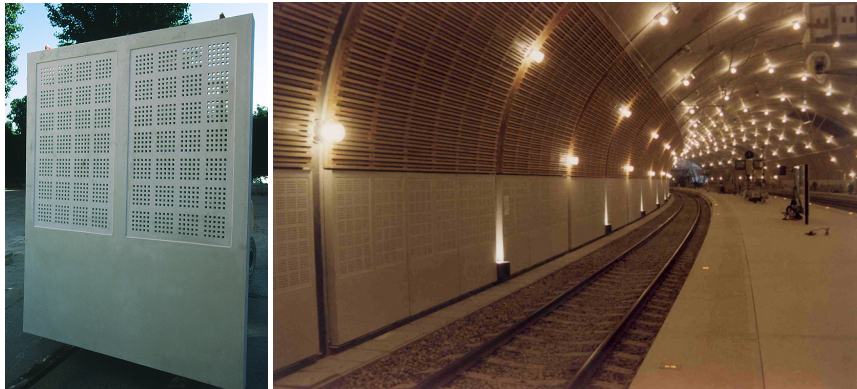
Bild 2.25: Lärmschutzwände im Hauptbahnhof von Monaco [2.22]
