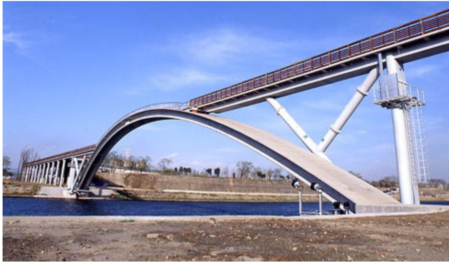
Bild 2.12: Ansicht der fertigen Seonyu-Fußgängerbrücke [2.22]
