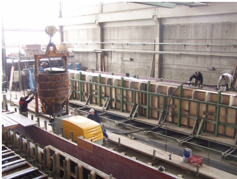
Bild 4.6: Stehende Schalung für die 2,20 x 5,00 x 0,08 m großen Deckenplatten der Gärtnerplatzbrücke in Kassel (Fa. ELO Betonwerk, Eichenzell)
