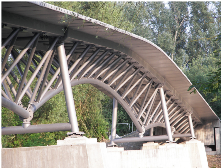
Bild 2.20: Mittelteil der Brücke (Flussöffnung) mit aufgelegten Fahrbahnplatten
