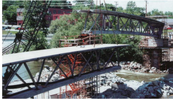
Bild 2.11: Einheben einer aus drei Einzelsegmenten bestehenden Brückenhälfte [2.4]
