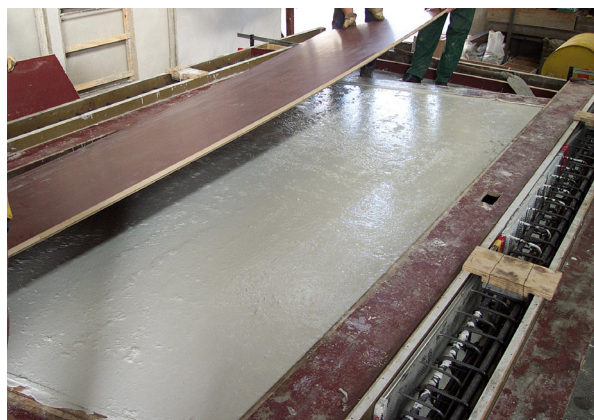
Bild 4.11: Abdecken einer freien UHFB-Oberfläche mit Folien und Schalungstafeln
