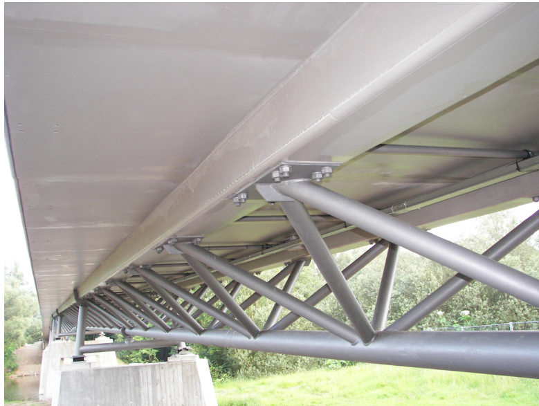
Bild 2.22: Stahlfachwerk, Schraubverbindungen zum Obergurt
