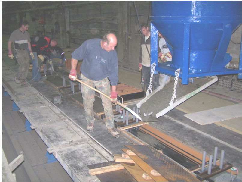
Bild 4.8: Betonieren der bis zu 36 m langen, vorgespannten Obergurte (Fa. ELO Betonwerk, Eichenzell)
