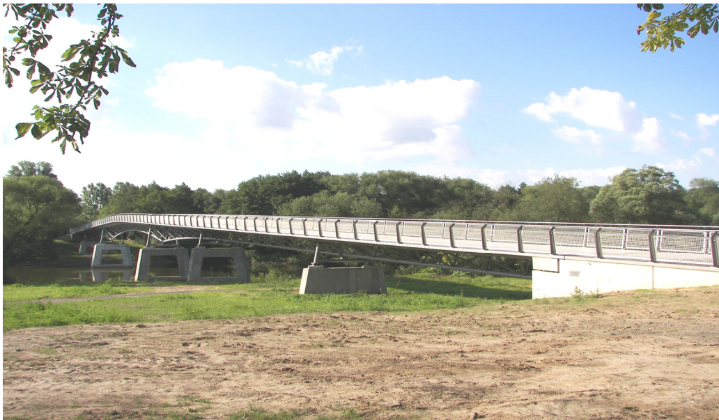
Bild 2.17: Gärtnerplatzbrücke über die Fulda 2007
