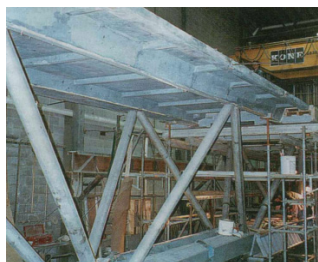
Bild 2.9: Brückensegment nach dem Ausschalen [2.3]
