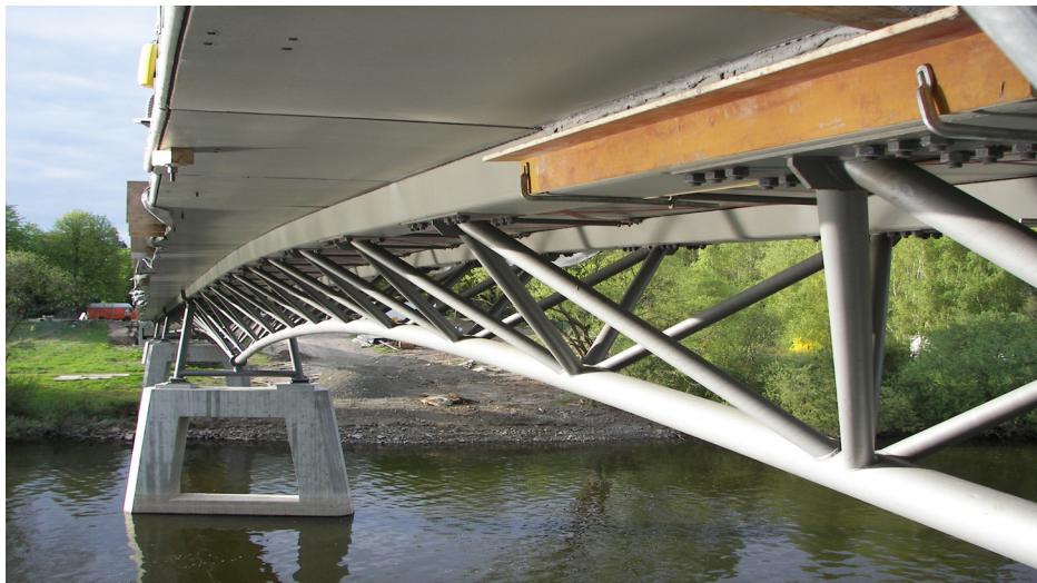
Bild 2.23: Klebefuge zwischen Obergurt und Fahrbahnplatten während des Verklebens
