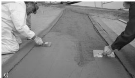
Bild 97. Ausführung der Textilbetonverstärkung im nördlichen Bereich der Schale; a) Aufbringen der Feinbetonschicht, b) Einlegen der textilen Bewehrung, c) Einbetten der textilen Bewehrung, d) Aufbringen der letzten Feinbetonschicht
