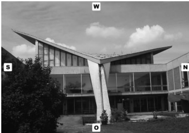
Bild 93. Ansicht des instand gesetzten Hörsaalgebäudes der Fachhochschule Schweinfurt vor der Maßnahme
