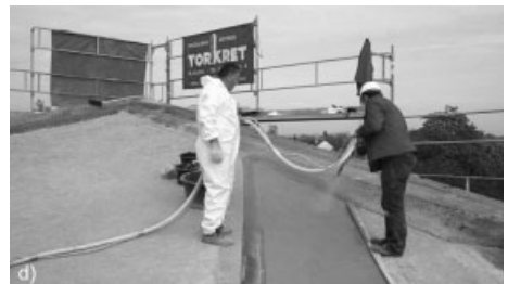
Bild 97. Ausführung der Textilbetonverstärkung im nördlichen Bereich der Schale; a) Aufbringen der Feinbetonschicht, b) Einlegen der textilen Bewehrung, c) Einbetten der textilen Bewehrung, d) Aufbringen der letzten Feinbetonschicht
