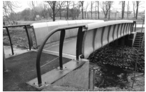
Bild 5. Ansicht der ersten Textilbetonbrücke; Konstruktionsformen für Textilbeton müssen sich noch weiterentwickeln
