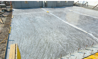
Recouvrement d'une dalle au moyen d'une feuille plastique
