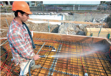
Mouiller le coffrage et les armatures au préalable
