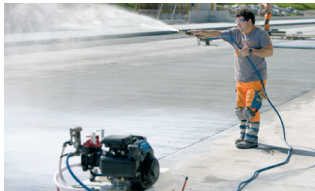
Vaporisation d'un produit de cure d'une feuille plastique
