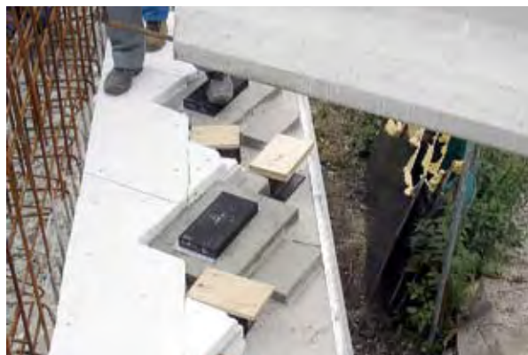
Photo 6 : cales provisoires pour les poutres de rive – Source : Séttra
