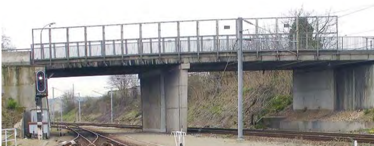
Photo 1 : vue générale de l'ouvrage existant – Source : Sétra
