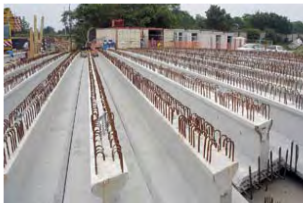
Photo 4 : stockage des poutres sur chantier – Source : Séttra
