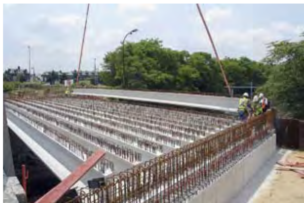
Photo 5 : pose des poutres – Source : Séttra
