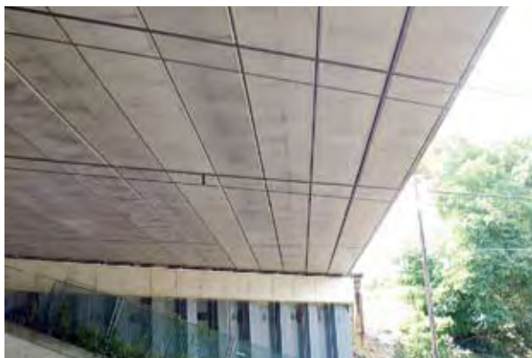
Photo 7 : sous-face du tablier – Source : Séttra
