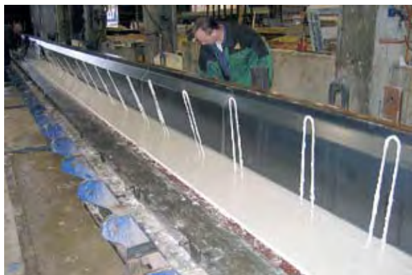
Photo 3 : mise en place de la partie supérieure du coffrage Source : P. Gilleron (LRPC de Rouen)
