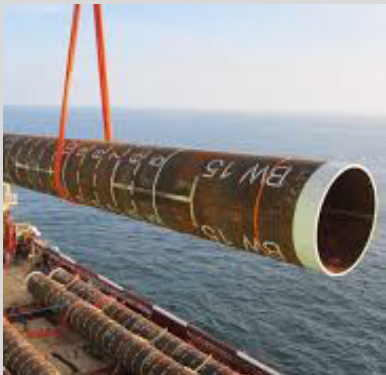
Pile anchors
