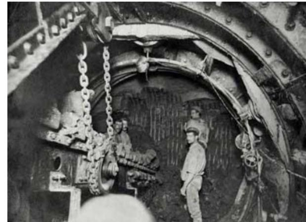
En 1864 James Henry Greathead démarre le creusement d'un tunnel circulaire revêtu d'un anneau de voussoirs en acier circulaire et boulonné. Le bouclier s'appuie et avance en s'appuyant sur le voussoir, et le front est stabilisé par une pression d'air. Ce tunnel sous la Tamise est généralement considéré comme le fondateur des tunnels moderne en sol.
